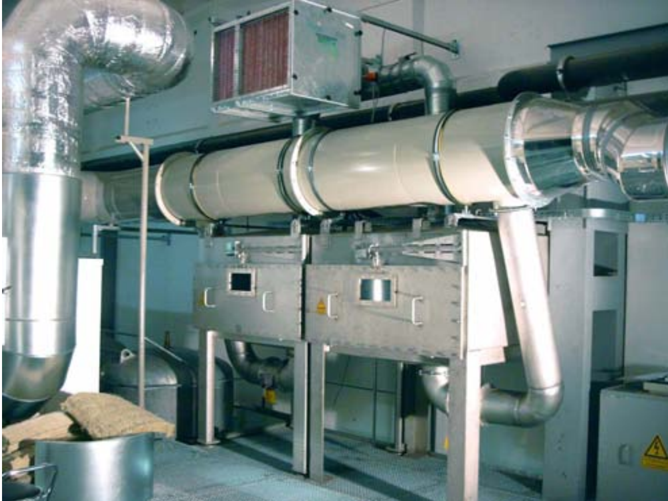
NTP-Stufe einer plasmakatalytischen Abluftreinigungsanlage Fa. IPC, Dresden
