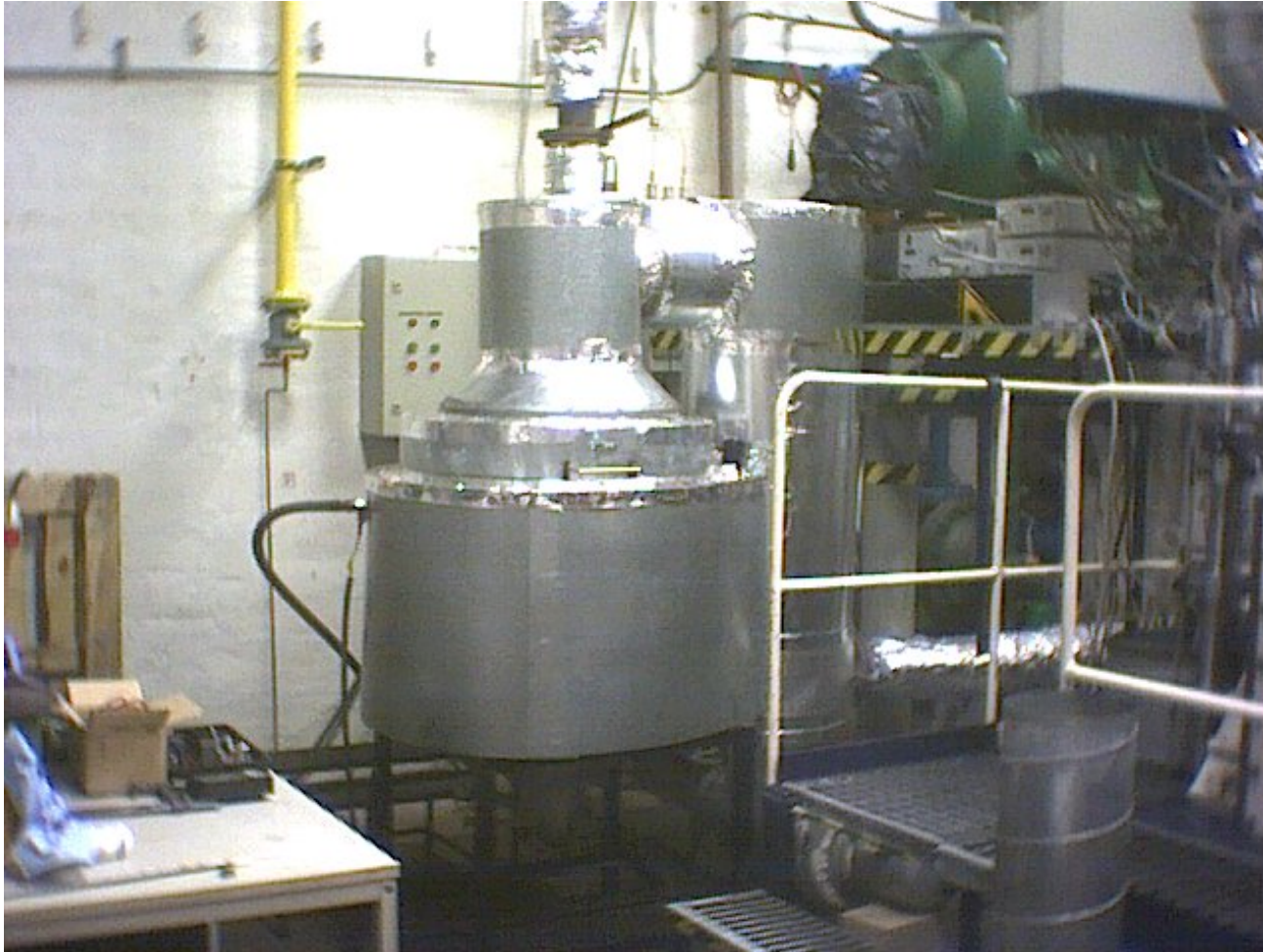
Anlage mit Reaktor für 2 Module, mit Isolationsmantel; Versuchsaufbau bei Fa. WTZ, Roßlau, angeschlossen an die Abgasquelle (Motorenprüfstand)
